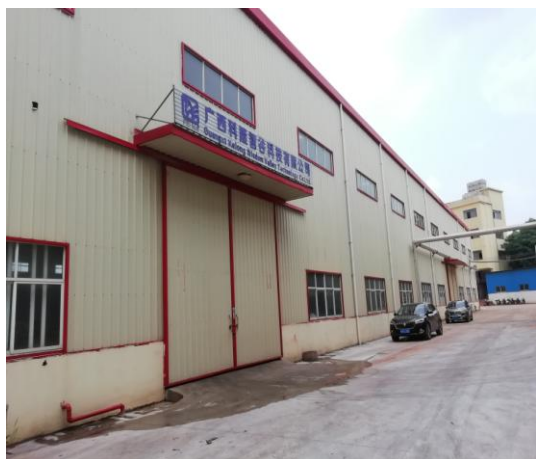
项目东面现状
