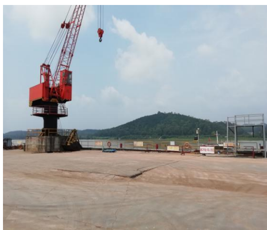
项目西面现状
