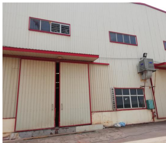
项目南面现状
